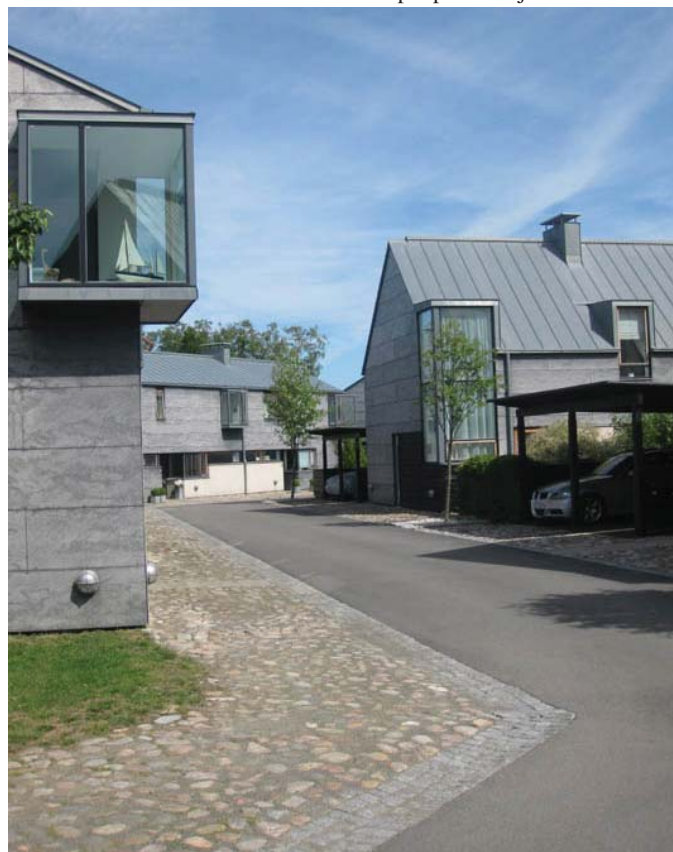
Exempel på gaturum och arbete med markbeläggning
